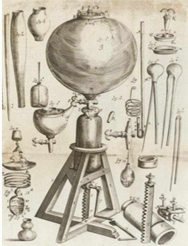
**Figura 15: Bomba de ar de Boyle, projetada e construída por Robert Hooke.**
